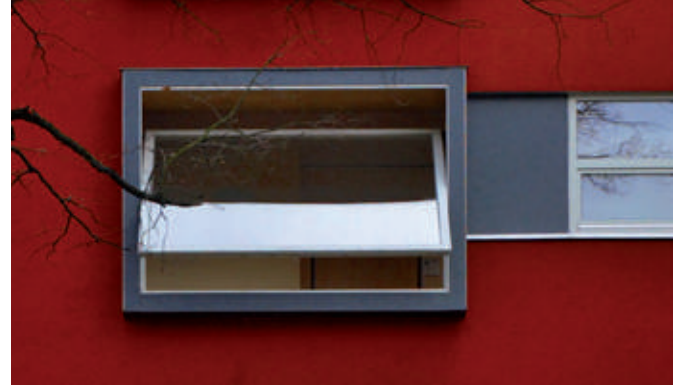
300 kg'a kadar kanat ağırlıkları için yatay pivot pencereler
